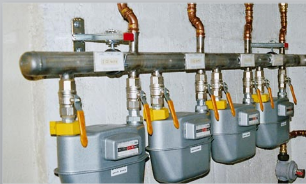
Praktisch in der Montage, sicher in der Anwendung: der Zweirohr-Reihenverteiler als eine Variante des patentierten Edelstahl-Gasverteilers von GAS Protect.
